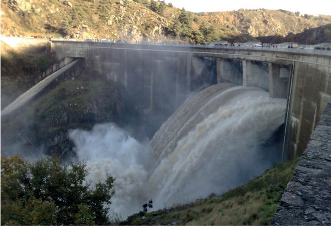
Construit dans les Gorges de la Loire, le barrage de Grangent mis en eau en 1957 a été concédé à EDF. Il a une triple vocation : hydroélectricité, tourisme et alimentation du canal du Forez. Il n'a pas de rôle "écrêteur de crues" comme celui de Villerest. Les débits sortants sont égaux aux débits entrants.
