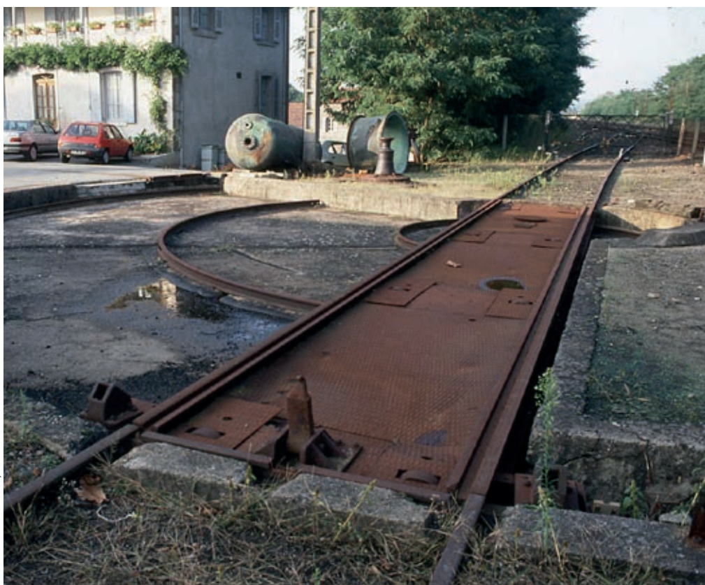
La plaque tournante permettait de dispatcher les wagons dans l'usine. Le train a été à une époque d'une importante capitale pour la féculerie Nigay.
