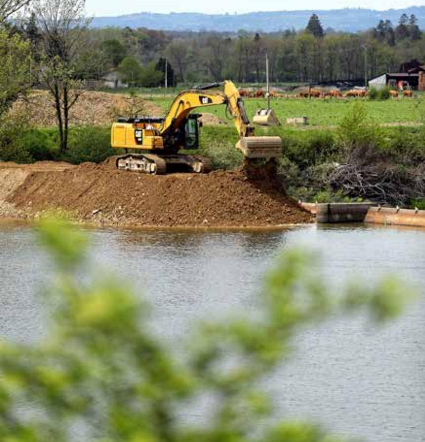
La seconde phase du chantier du barrage sur la Loire vient de débiter. Elle va se dérouler suivant un schéma similaire à celui de l'an passé. D'imposants engins de terrassement sont entrés en action pour construire le batardeau – nécessitant pas moins de 10 000 m<sup>3</sup> de terre – qui va permettre d'isoler les cinq dernières vannes.
