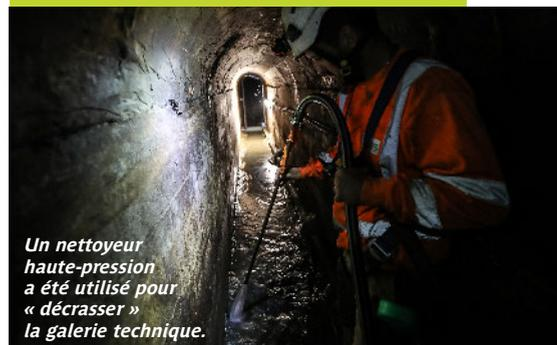
*Un nettoyeur haute-pression a été utilisé pour « dégraisser » la galerie technique.*
